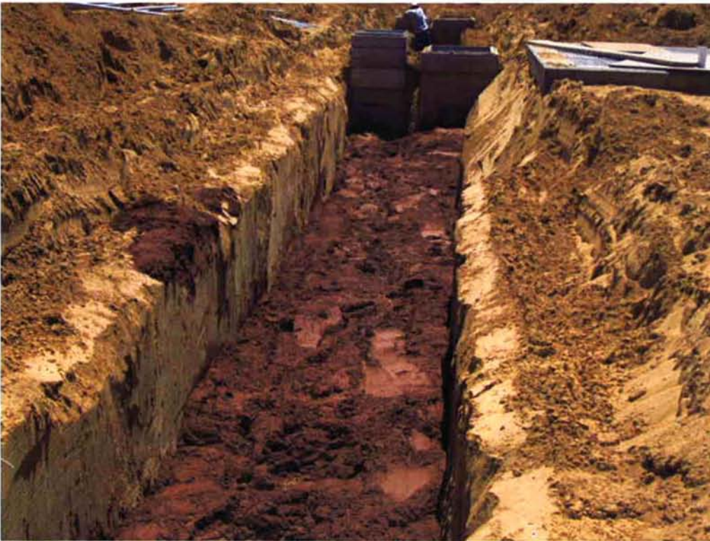
Bergelectric pouring red slurry over electrical conduit Duct Banks #16 & 22.
