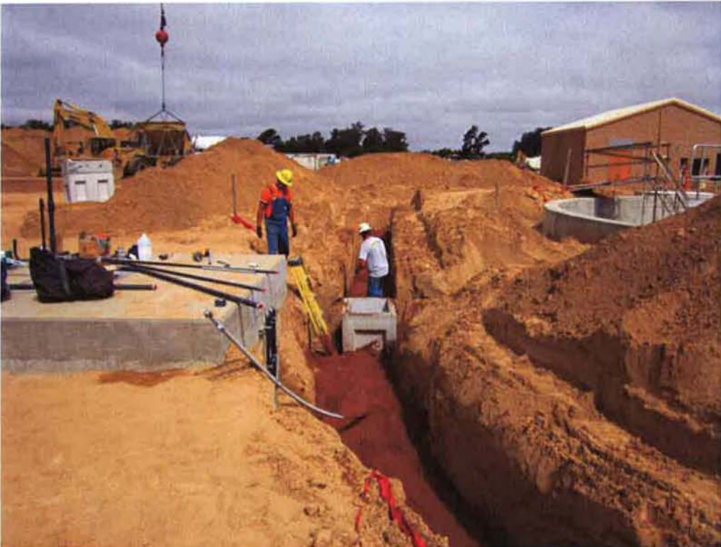
Bergelectric pouring red slurry over DB-24.
