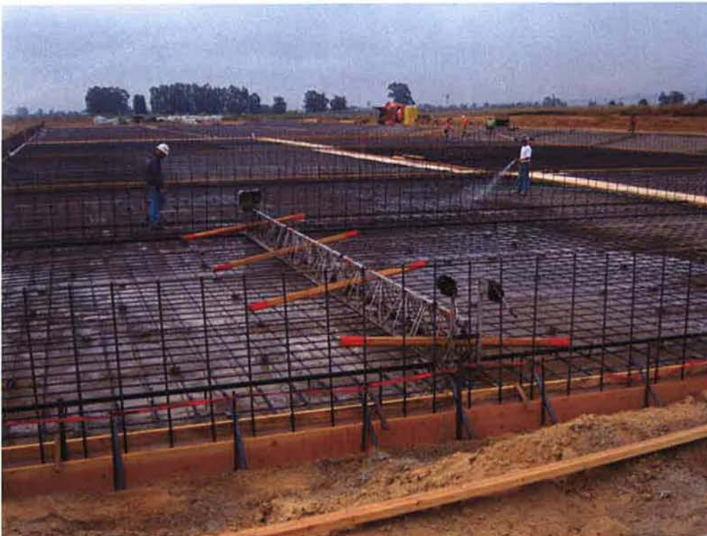
Cushman preparing for night pour of Sludge Drying Beds.
