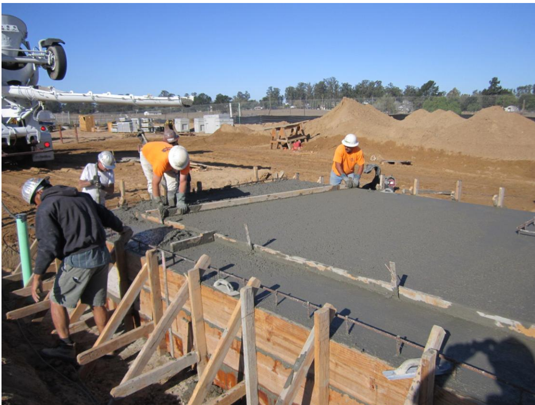
Cushman pouring the Grit Classifier slab.
