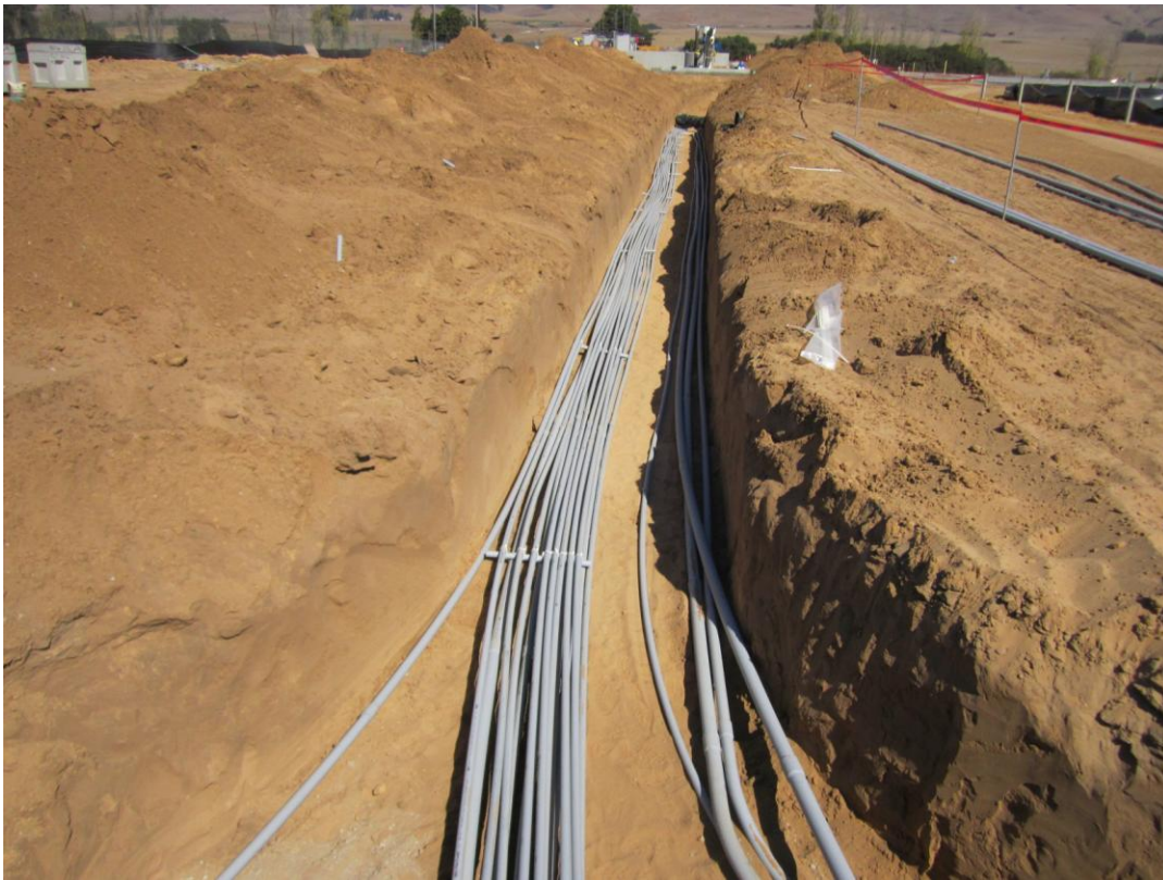
Bergelectric installing conduit for DB 02.
