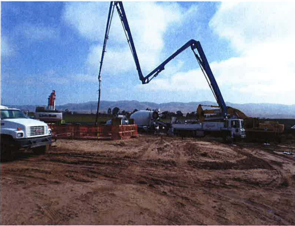
Spiess pouring pump can encasements.
