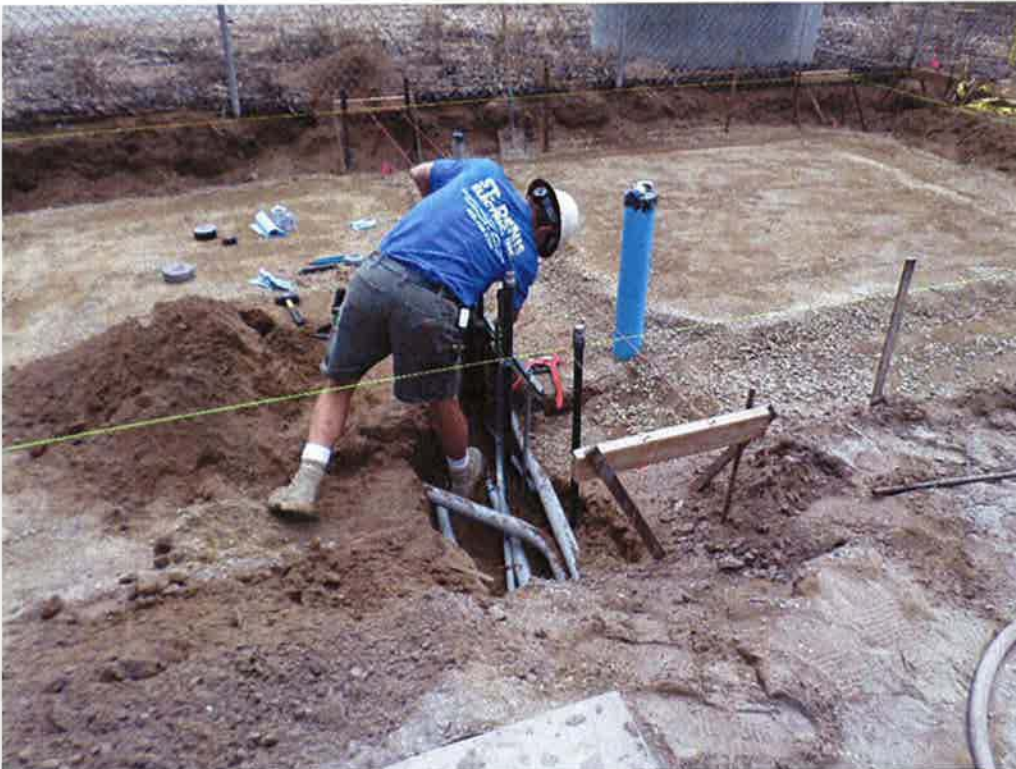
Spiess installing underslab conduit.
